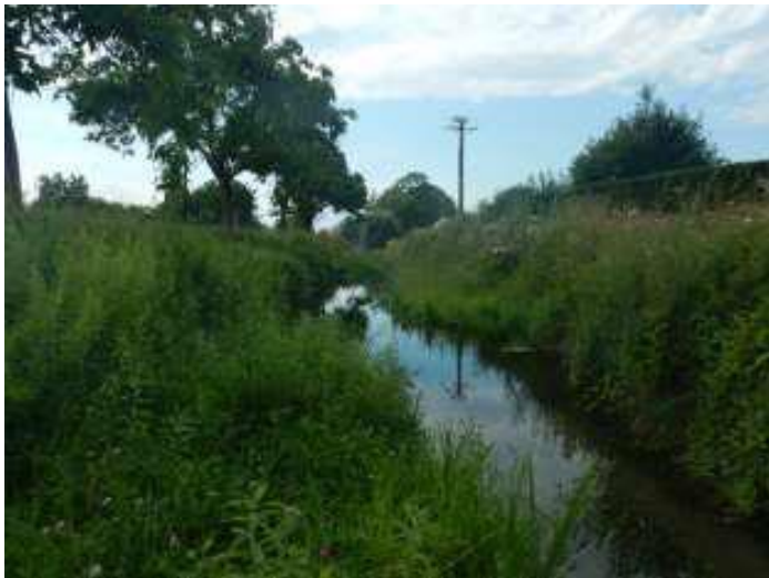
Hanenfröse (après travaux).
