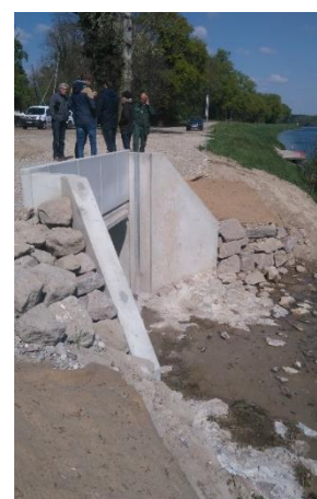
Nouvelle prise d'eau amont
