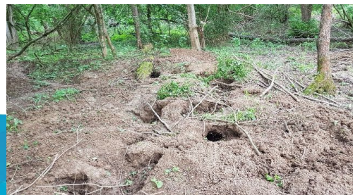
Tracé décalé pour éviter le terrier d'un blaireau
