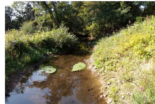
Abaissement de 75 cm du fond du lit
