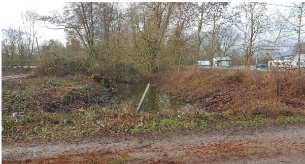
Buses calées trop hautes, effet de seuil et envasement
